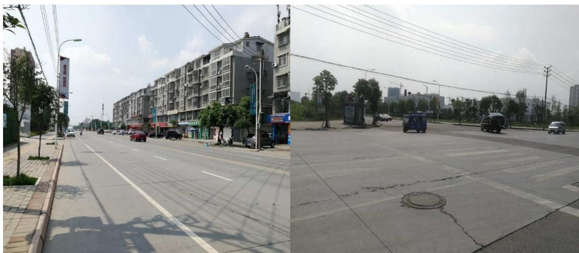
改建段道路现状
